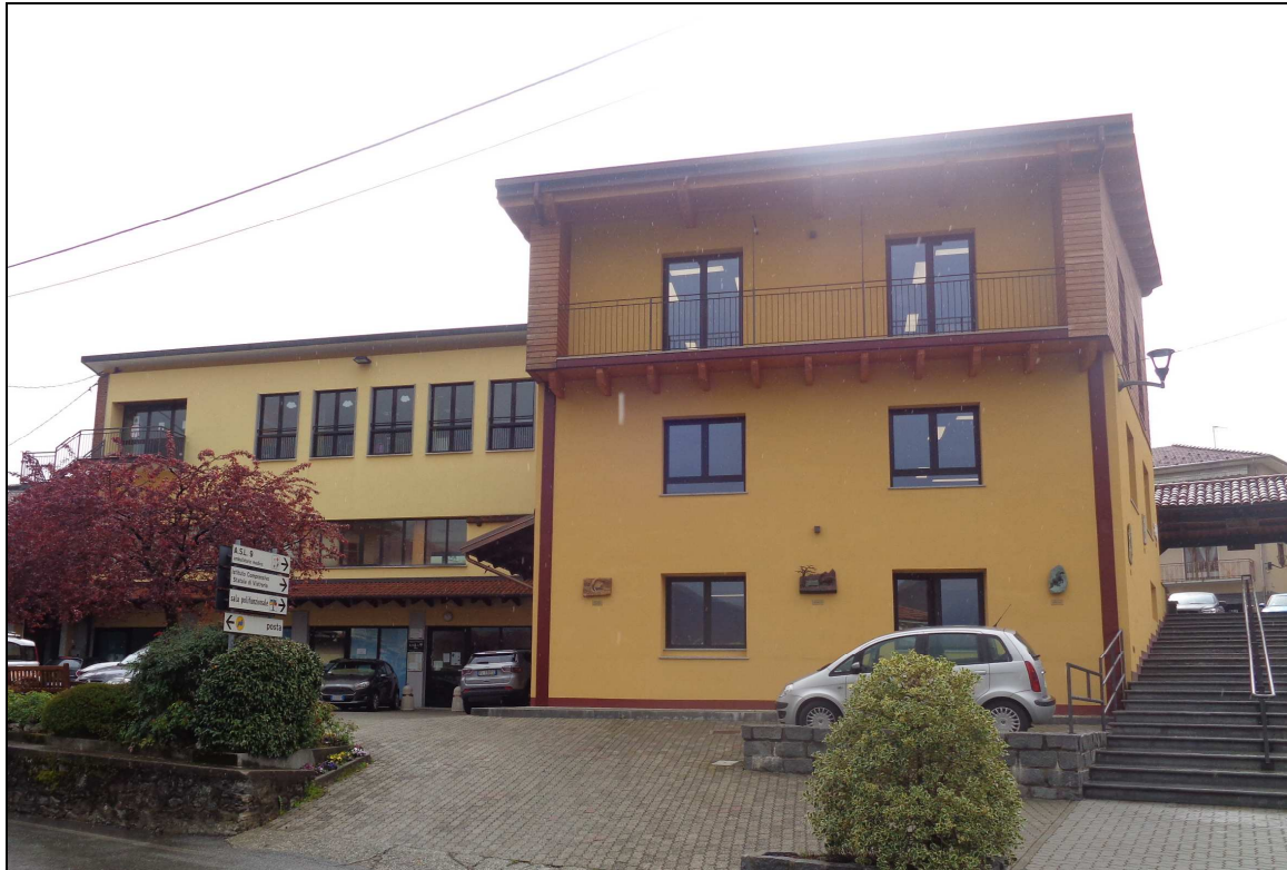
Vista edificio da via Garibaldi
