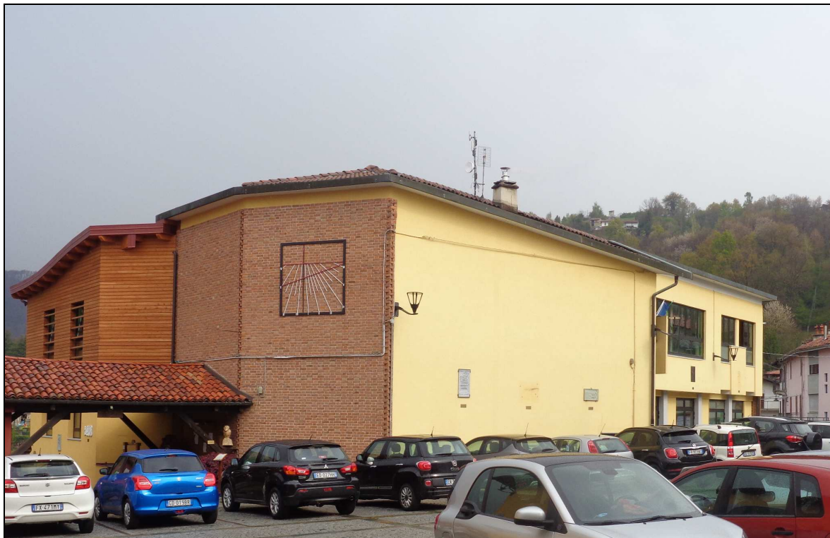
Vista Sud-Ovest dell'edificio
