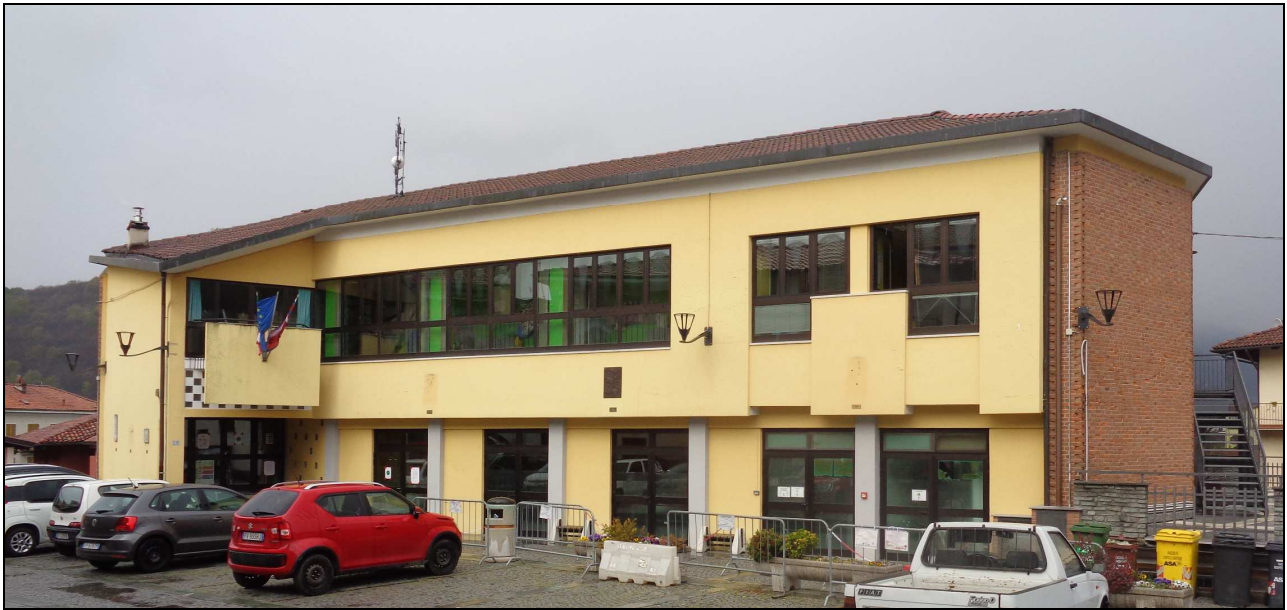
Vista Sud-Est dell'edificio
